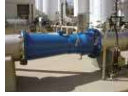
الشكل (33): مقياس فنتوري في إحدى محطات المياه.
